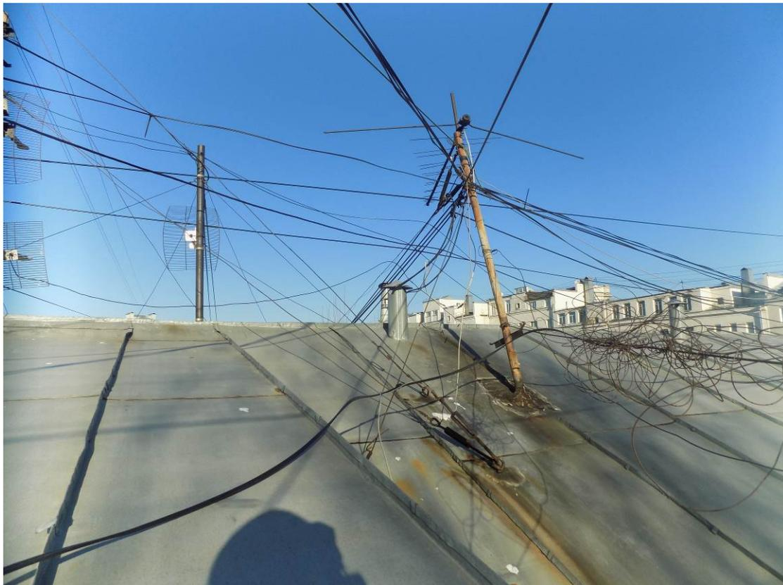
**Фото 20, 21. Коррозия оцинкованного покрытия кровли**
