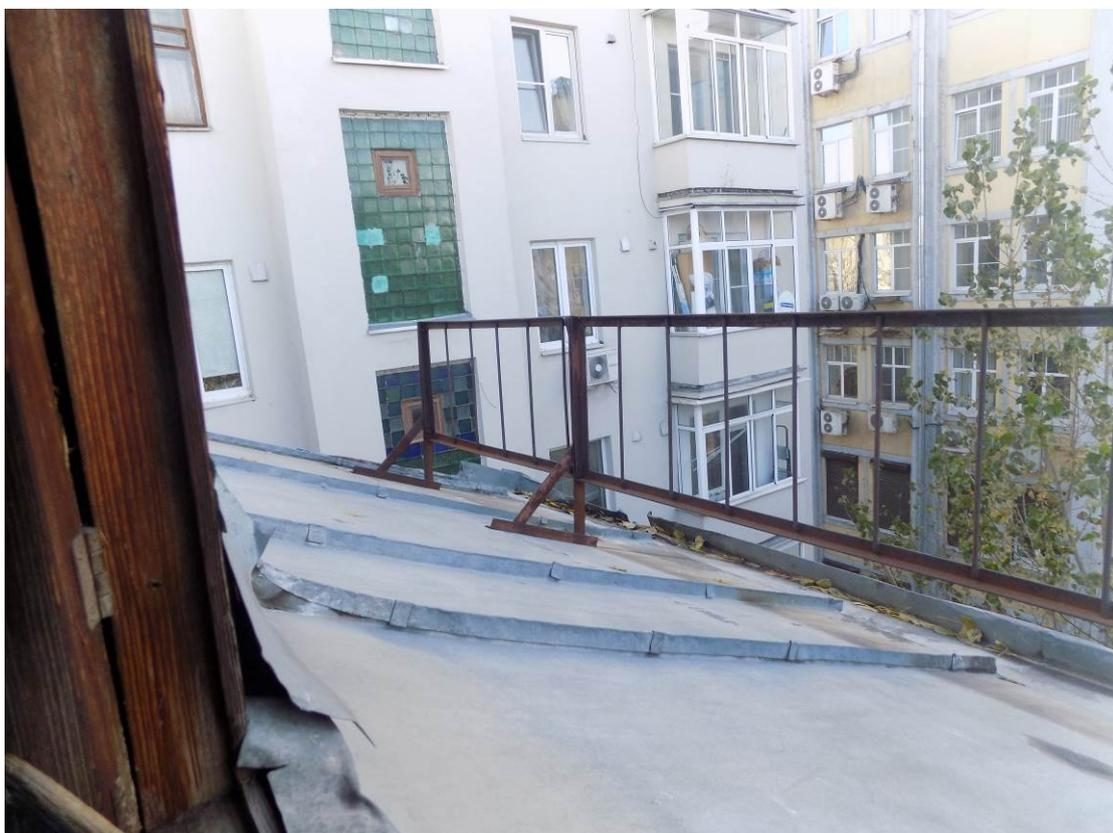
**Фото 22. Коррозия металлического ограждения**
