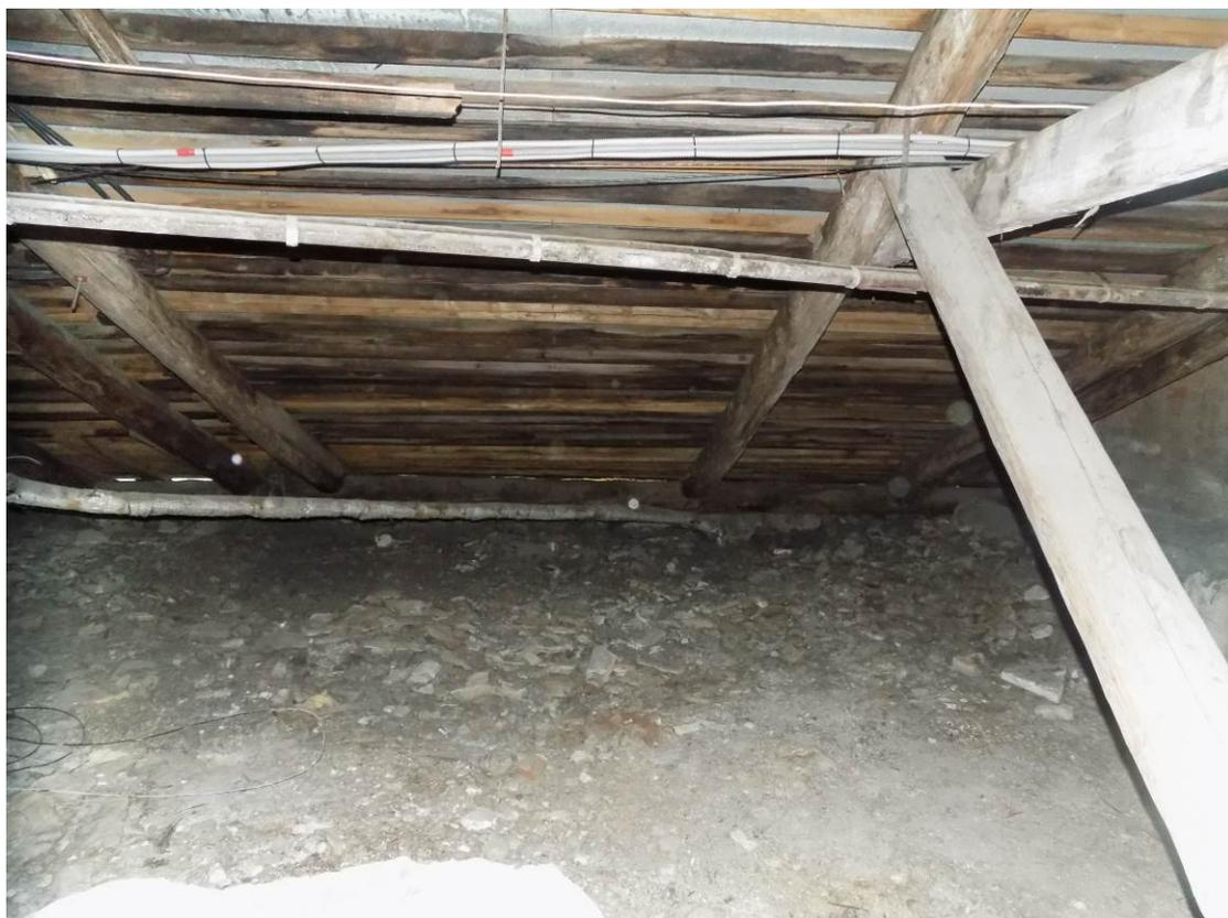
**Фото 17. Обильное замокание, гниение деревянной обрешетки.**
