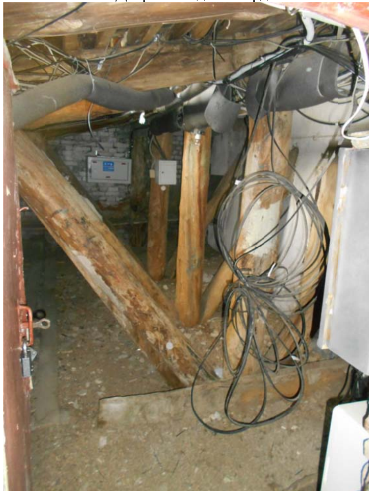
22. Общий вид чердачного помещения
