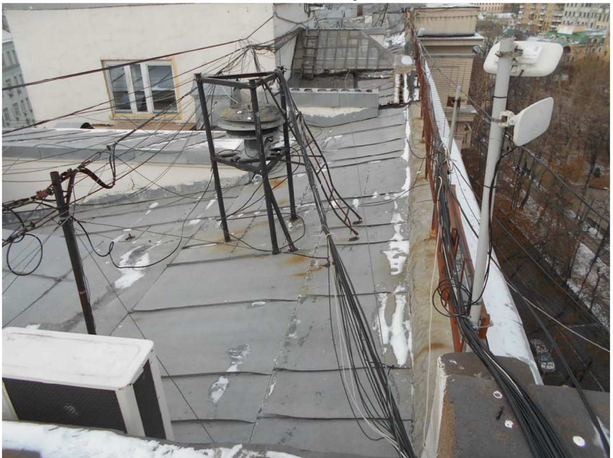
32. Общий вид кровли
