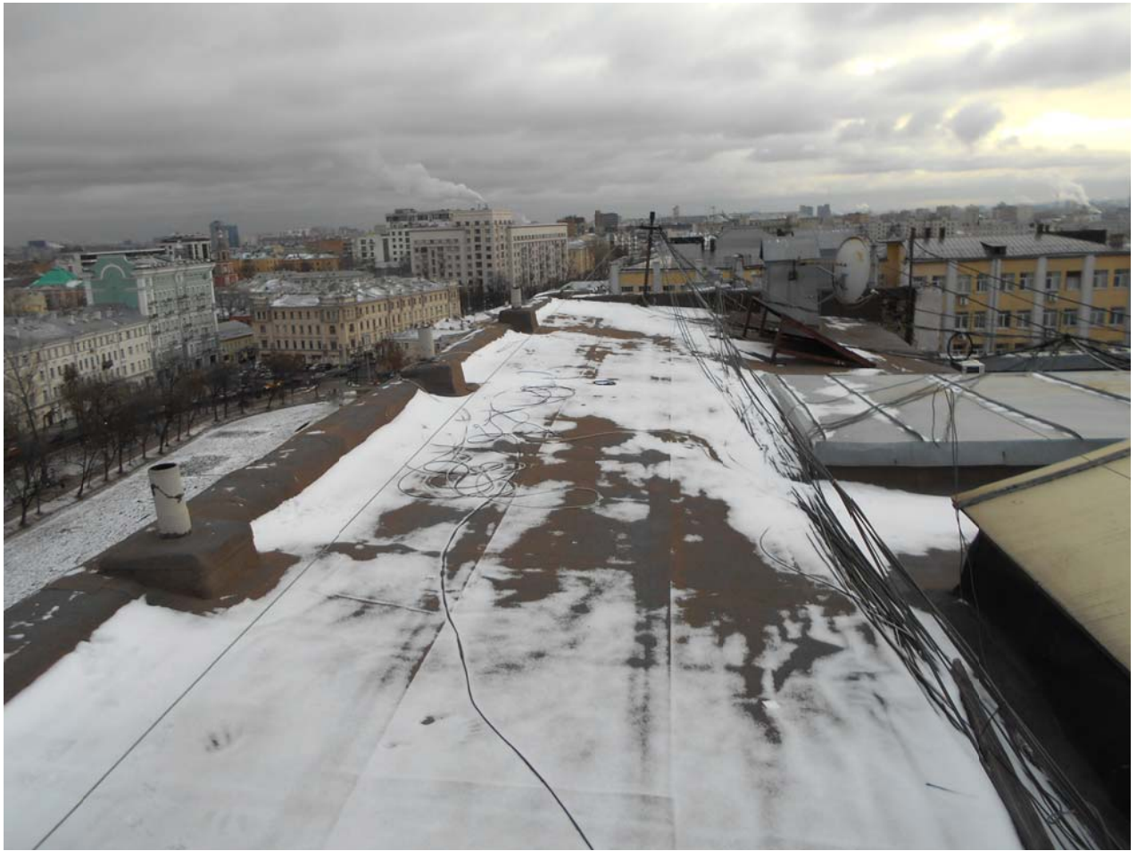
31. Общий вид кровли
