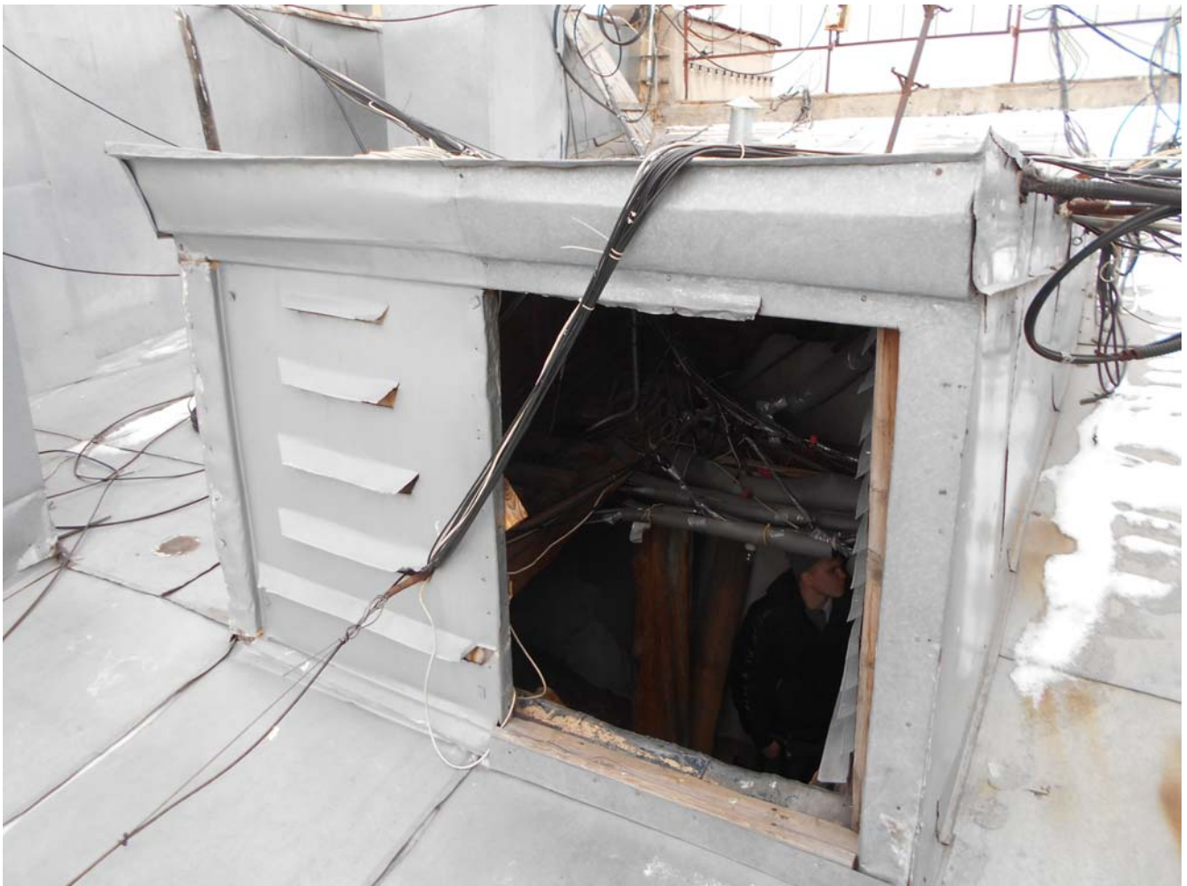
26. Фасад в осях «Ж-Д» и «6-4»
