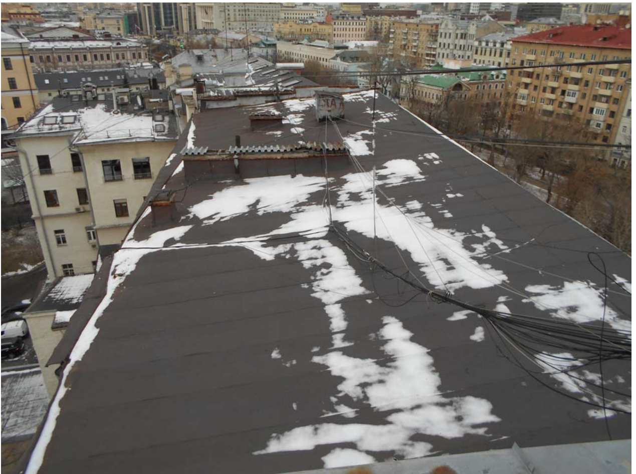
28. Общий вид кровли
