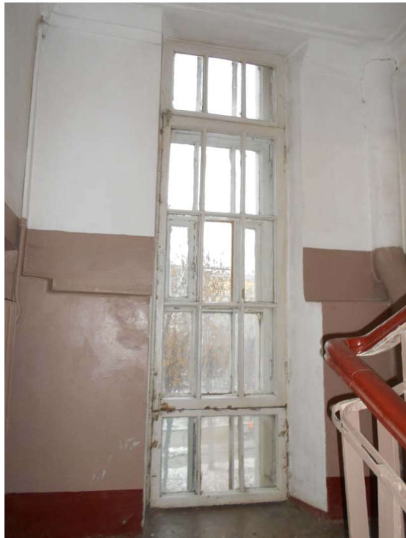
20. Деревянное заполнение окон
