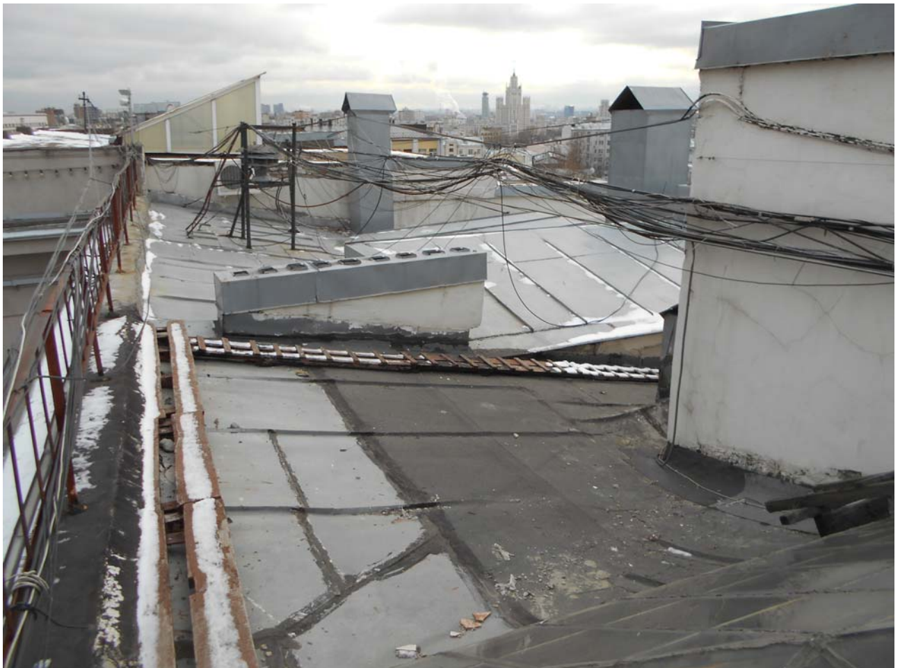
30. Общий вид кровли
