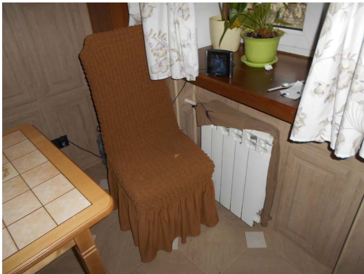
37. Прибор отопления в квартире
