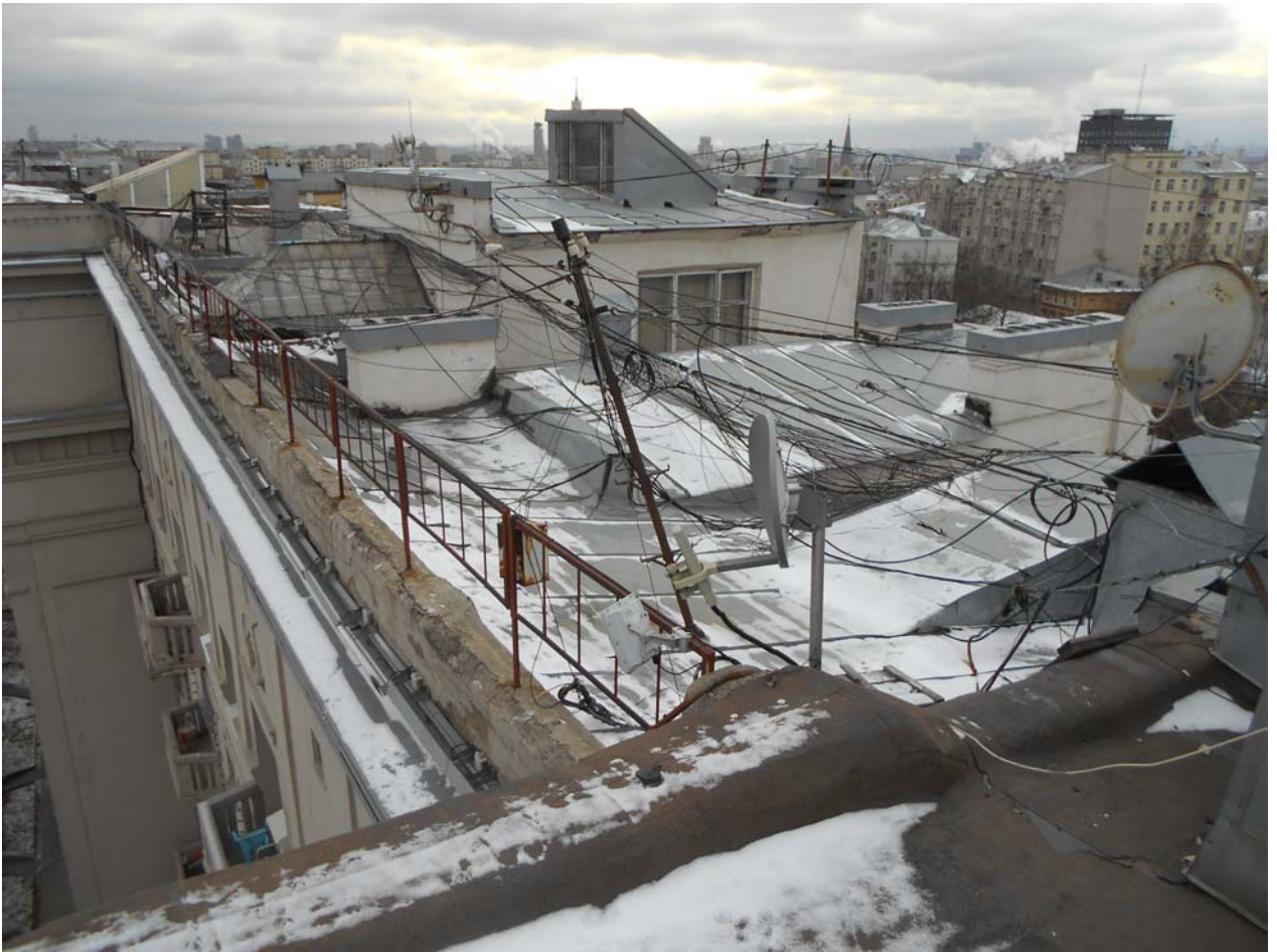
27. Общий вид кровли
