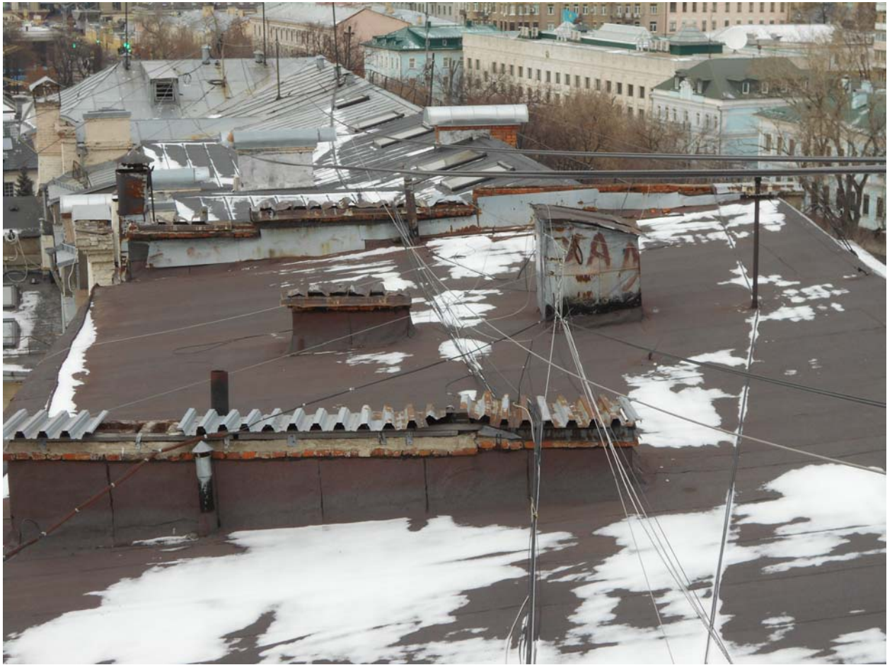
29. Общий вид кровли
