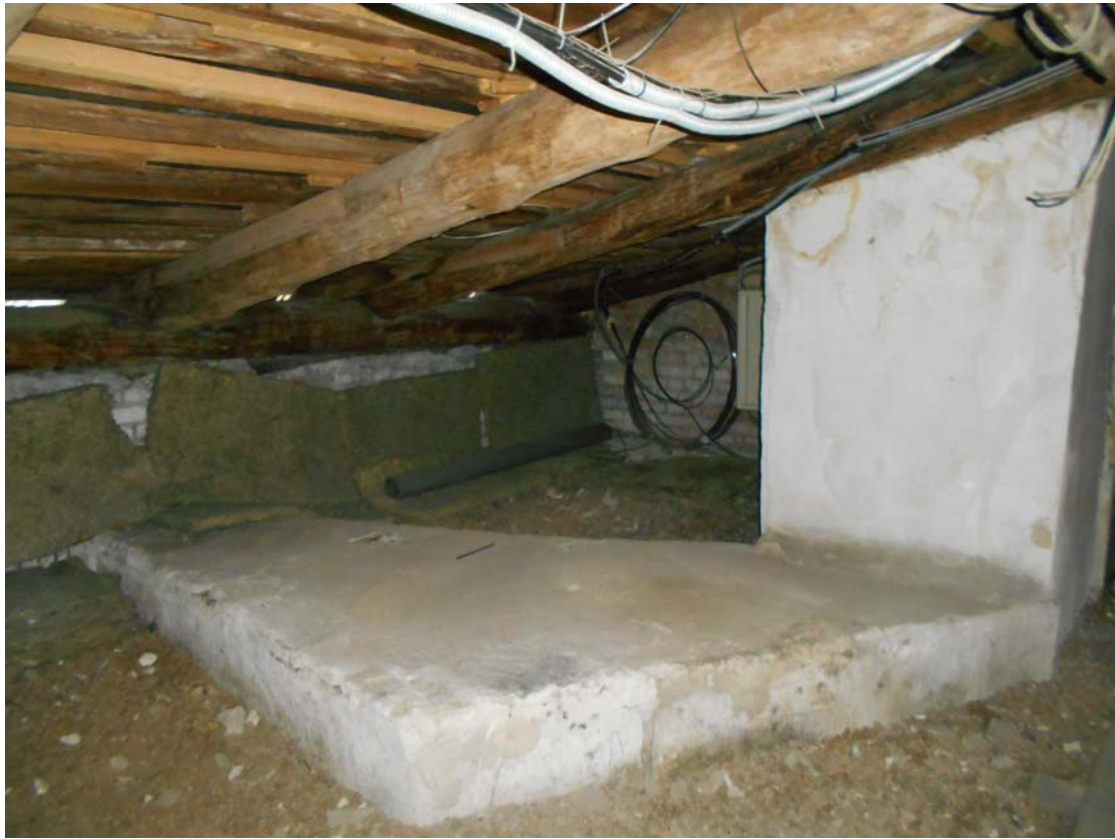
23. Общий вид чердачного помещения
