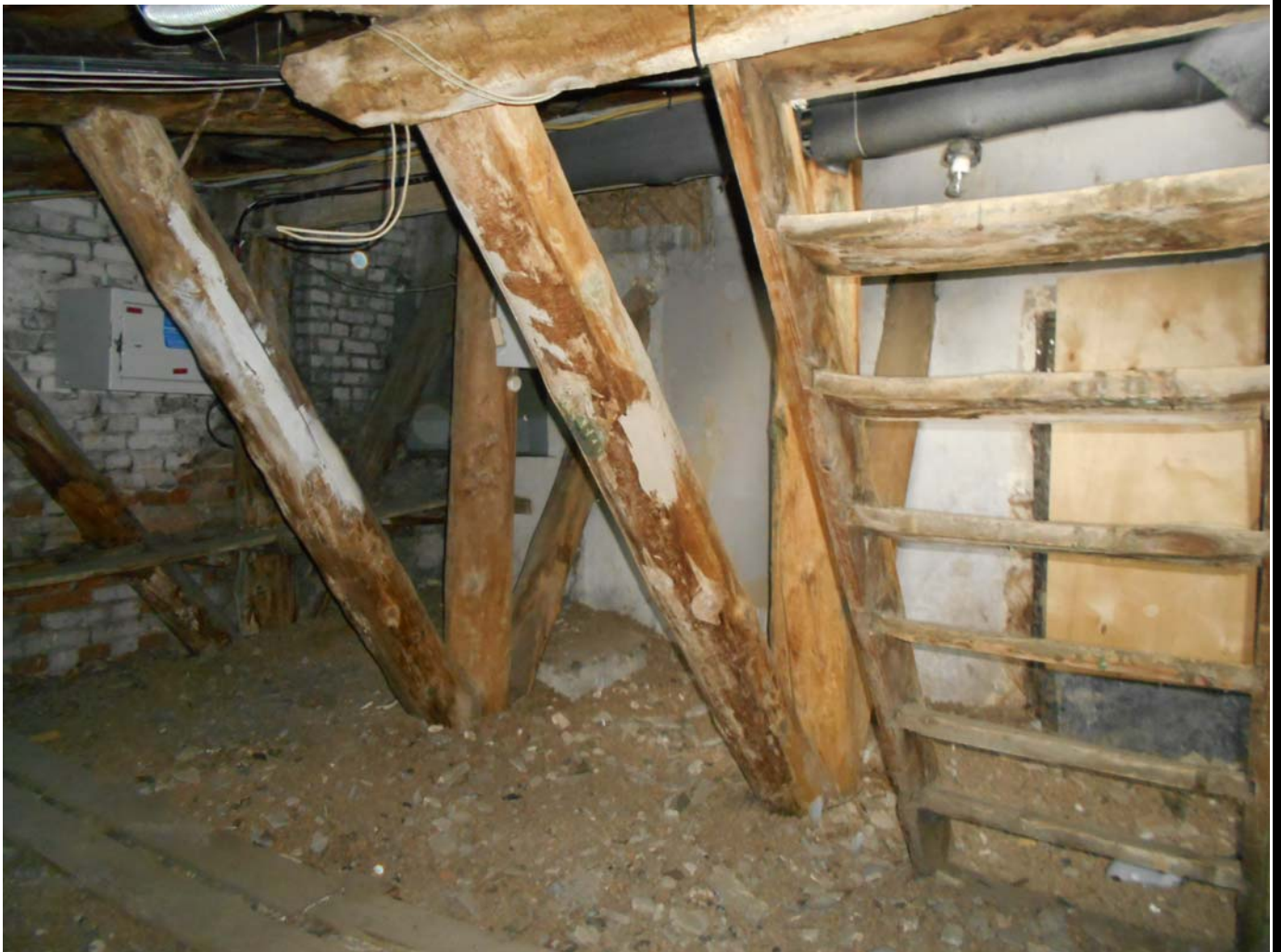
24. Общий вид чердачного помещения
