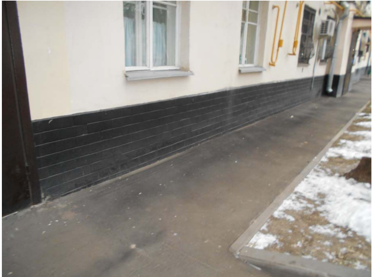
10. Состояние отмостки со стороны двора
