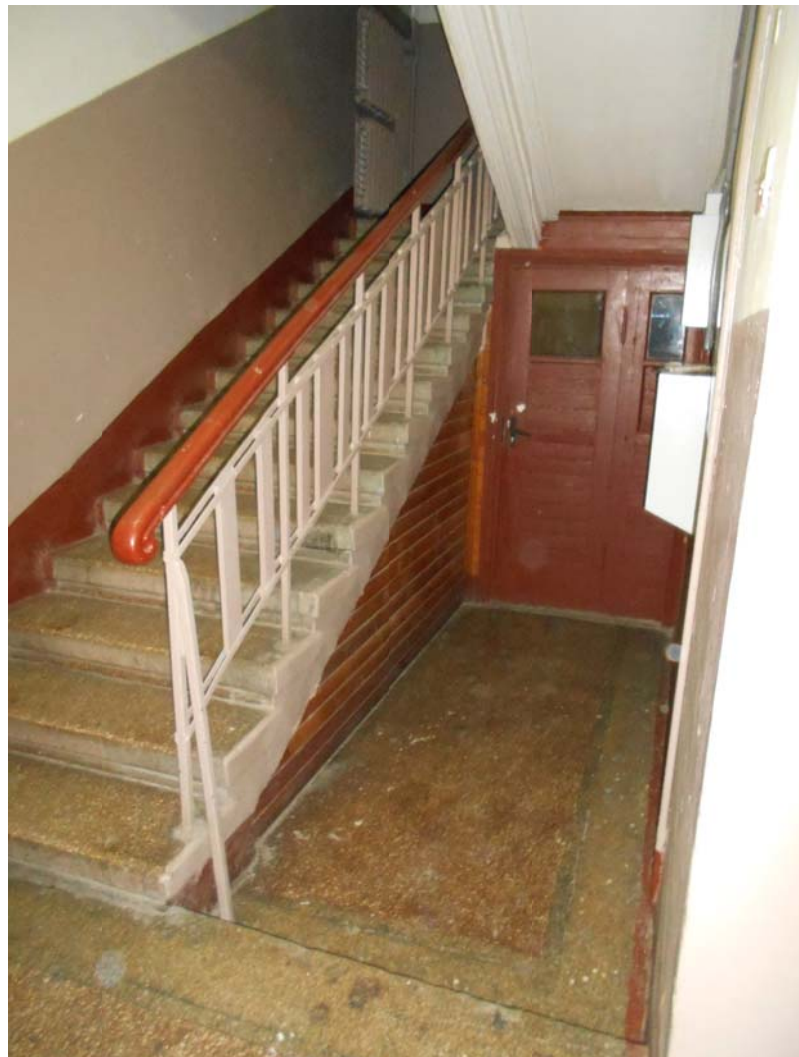
18. Лестничный холл 1-го этажа, тамбурная дверь
