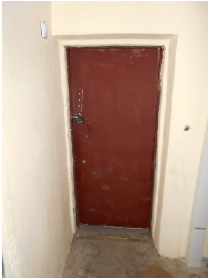
21. Дверь выхода на чердак
